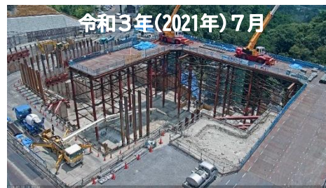
令和3年(2021年)7月 ▲地下・ステージ部分の土木工事を実施
