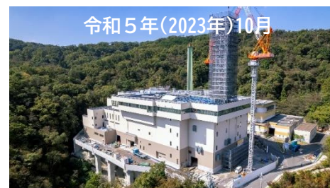
令和5年(2023年)10月 ▲煙突工事を実施
