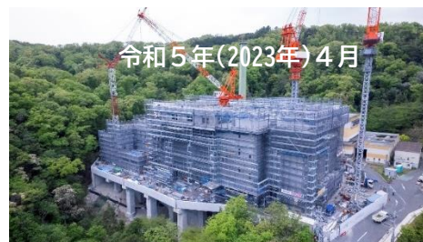
令和5年(2023年)4月 ▲屋根・外壁、プラント設備工事を実施
