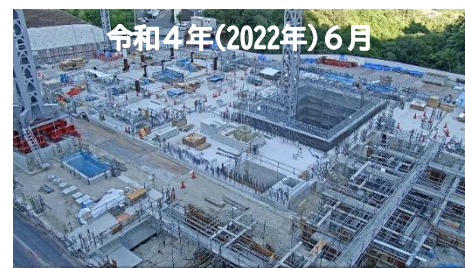
令和4年(2022年)6月 ▲鉄骨建て方、型枠・鉄筋・コンクリート打設を実施
