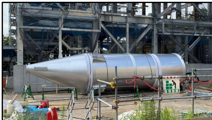
消石灰サイロ搬入
