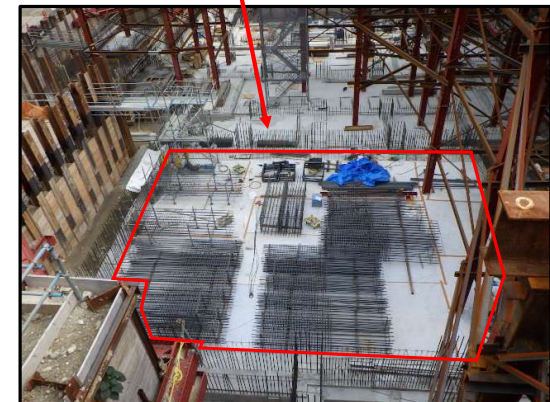
ごみピットの底盤部
