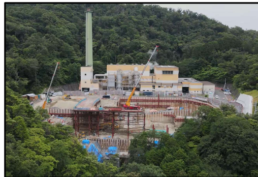
谷側から見た6月現在の状況
